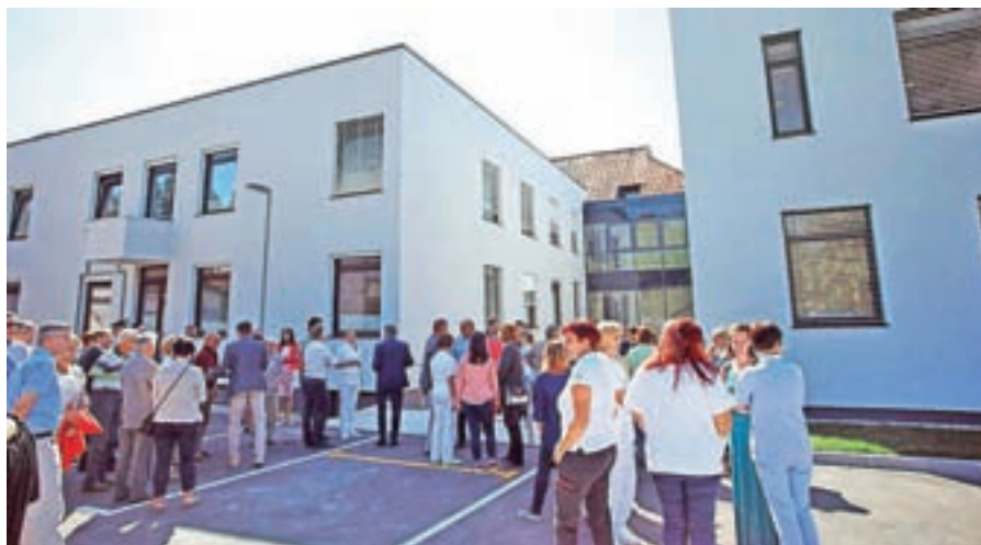
Jeseni je bil dokončan prizidek k Zdravstvenemu domu Radovljica.
