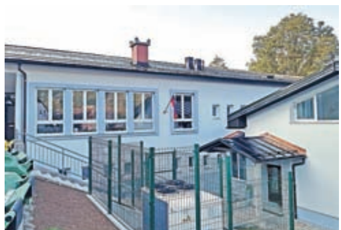
Podružnična šola Trstenik po sanaciji
