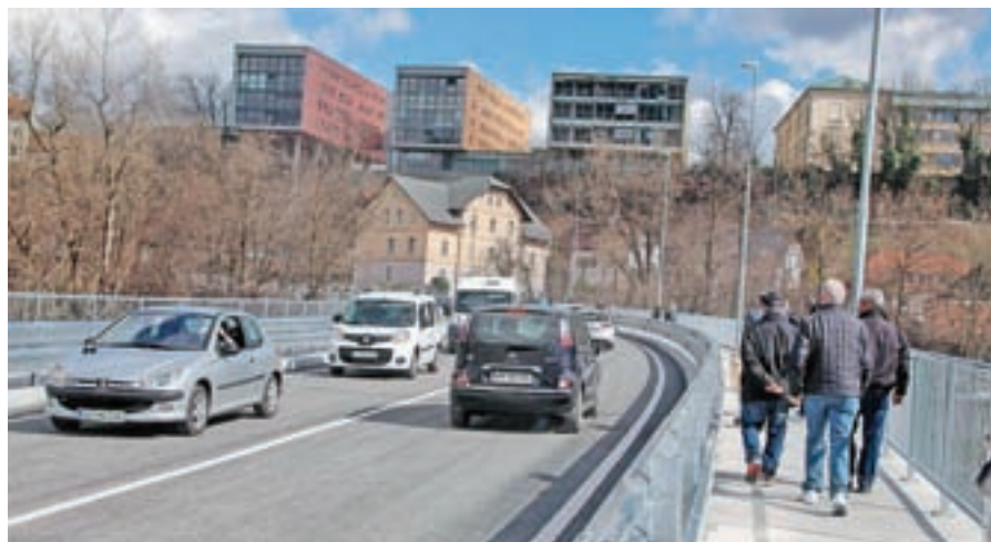
Nadvoz nad Savskim otokom je bil potreben prenove.
