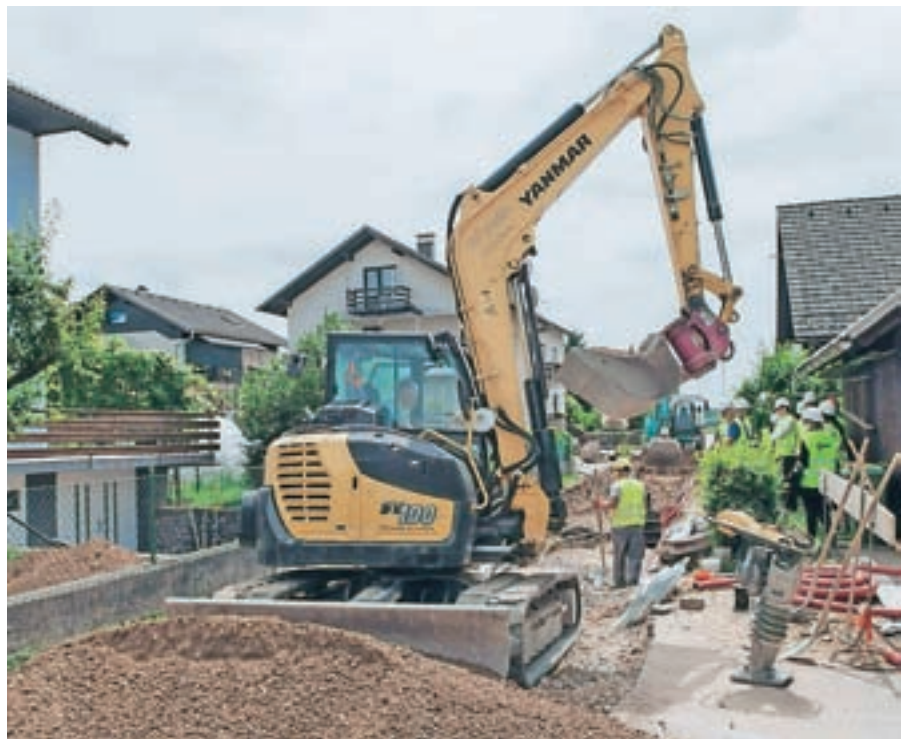
Dela pri projektu Gorki 2 so se na območju Britofa začela spomladi, nadaljujejo pa se v Predosljah in na Mlaki.
