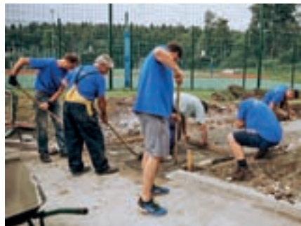
Izgradnja klančine pri OŠ Preddvor je potekala cel dan.
