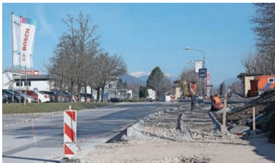
Rekonstrukcija Kidričeve ceste s kolesarsko stezo
