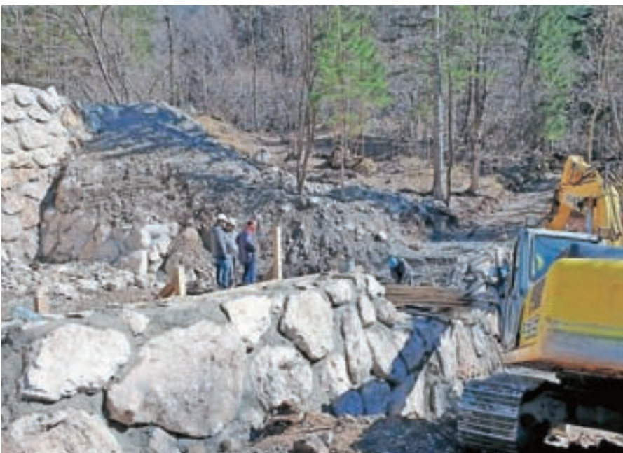
Obnova ceste skozi Jesenice in struge na Koroški Beli
