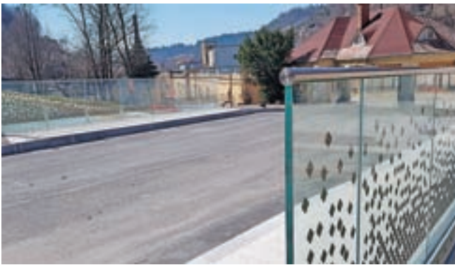
Severni most, ki predstavlja vhod v BPT, je po obnovi varen, nosilen in tudi z gradbenimi detajli povezuje preteklost s prihodnostjo. / Foto: arhiv Občine Tržič
