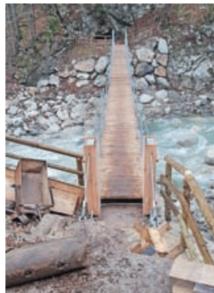
V obnovo cestne infrastrukture v Lomu in Dovžanovi soteski smo poleg dveh milijonov evrov državne pomoči vložili še več kot pol milijona iz občinskega proračuna. / Foto: arhiv Občine Tržič
