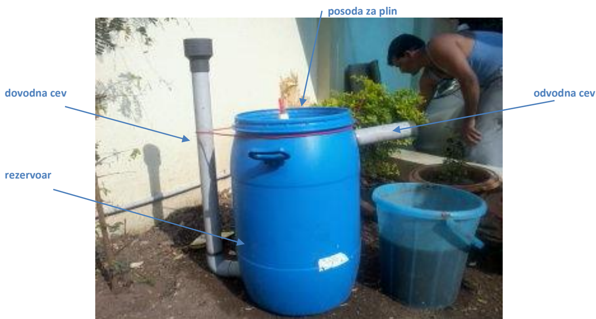
Slika 1 - Glavni elementi sistema.
