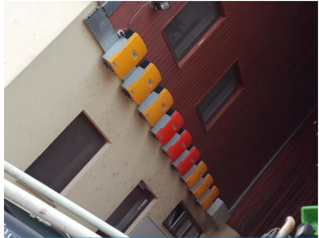
Sončna elektrarna Strahinj – razsmerniki na hlevu za govedo.
