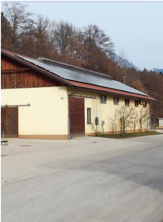
Sončna elektrarna Strahinj – fotonapetostni moduli na hlevu za konje.
