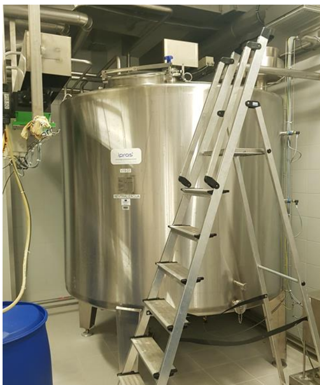
Slika 187: Nevtralizator v mlekarni Vir: Kaja T. Rozman (5. 06. 2021)
