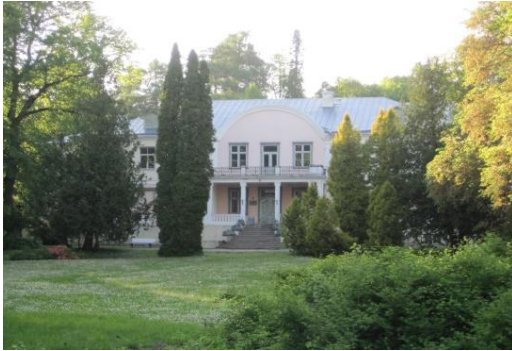
Šolsko poslopje – uprava šole in čudovit park.
