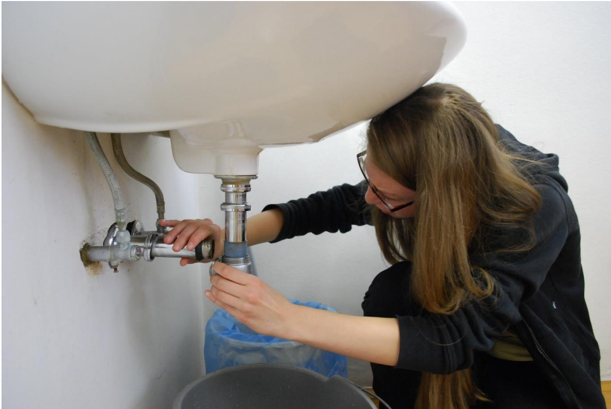
Slika 32: Čiščenje odtoka
