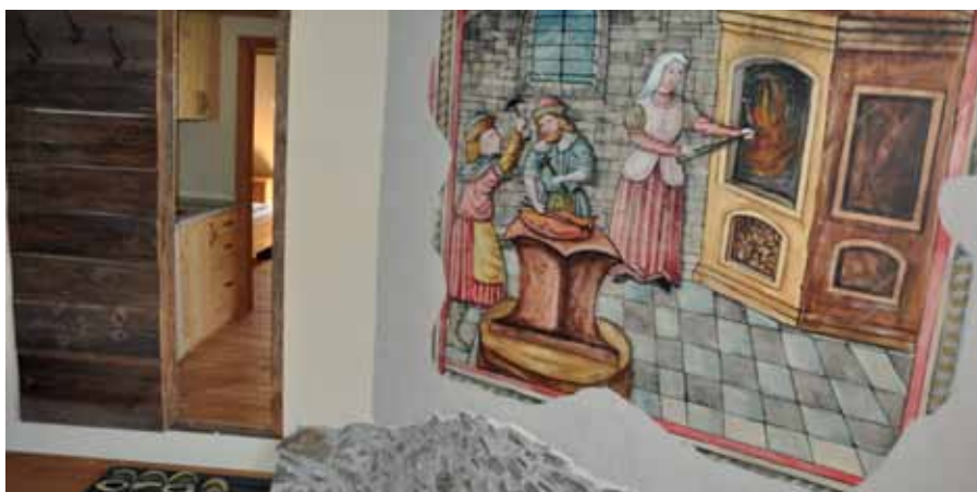
Slika 6: Polona Virnik Karničar: »Pri obnovi sob smo uporabili veliko starega lesa, večina ga je iz ostrejša stare hiše, tako da je star 350, 400 let. Iz starih tramov smo izdelali pohištvo. Bivša macesnova kritina strehe je bila uporabljena za lesene obloge. Uporabljeni so bili čisto unikatni elementi.«
