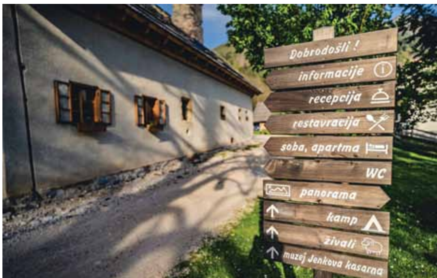
Slika 11: Prva stavba, ki so se je lotili, je bil stari volovjek, kamor so umestili kotlovnico in zalogovnik za ogrevanje na sekance ter sanitarije, zraven je prostor za kampiranje. Arhiv: Polona Virnik Karničar
