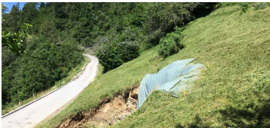
Slika 1. Prvotni gradbeni izkop za manjši gospodarski objekt. Izvajalec je bil prepričan, da ima vse pod kontrolo. Foto: F. Vidic, 2019
