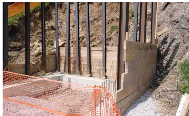
Slika 3. Prvi poskusi sanacije. V tla zabiti železni drogovji in opaži iz lesenih plohov so bili slaba začasna rešitev. Pobočje ni bilo stabilizirano in je narava ponovno pokazala, kaj zmore. Nadaljevalo se je izpiranje in rušenje zgornjega robu in kovinski drogovji so se začeli nagibati in kriviti. Šele ojačana železobetonska škarpa, drenaža in temeljita sanacija so umirile plazenje pobočja. Foto: F. Vidic, 2019
